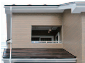
屋根は耐久性・速乾性に優れた「シリコンルーフ」で塗装。光沢が高級感を演出
