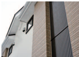
外壁の一部をダークブラウンに塗り替へ、建物全体の印象が引き締まった
